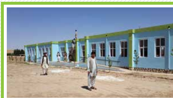
ساختمان مکتب، قریه کوسا قلعه، ولسوالی خواجه سبز پوش ولایت فاریاب
